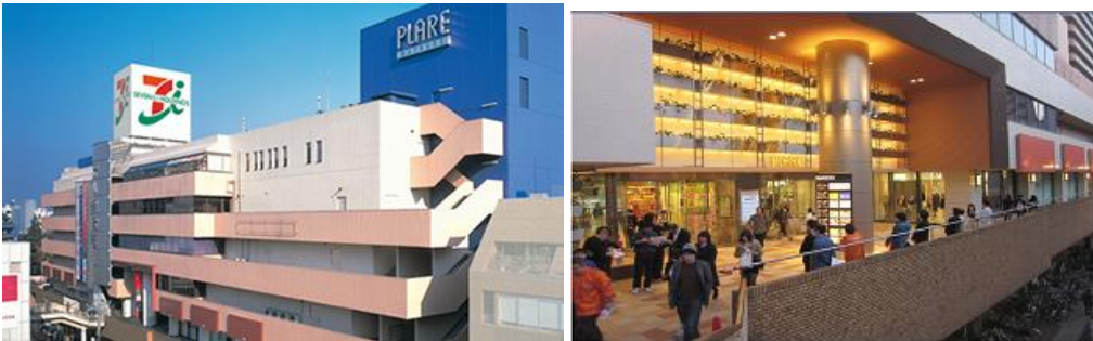
《左と中央：リニューアル後の「プラーレ松戸」の外観・2 階エントランス、 右：リニューアルのキービジュアル》
